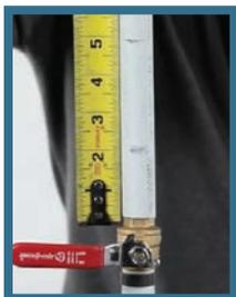
Mesurez la longueur du tuyau à couper et coupez le tuyau. Appliquez un ruban scellant de téflon sur les embouts et vissez solidement les embouts dans la valve à l'aide de la clé à molette. Insérez la valve dans la tuyauterie et sceller solidement avec collet de serrage pour conduit de pex.
