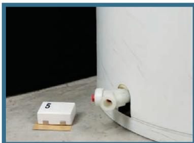
Si votre chauffe-eau est protégé par un bac, installez le capteur à l'intérieur du bac avec un velcro. Si votre chauffe-eau n'est pas protégé par un bac, installez le capteur au point le plus bas du plancher en vous assurant de protéger les contacts du capteur du béton avec l'autocollant fourni.
